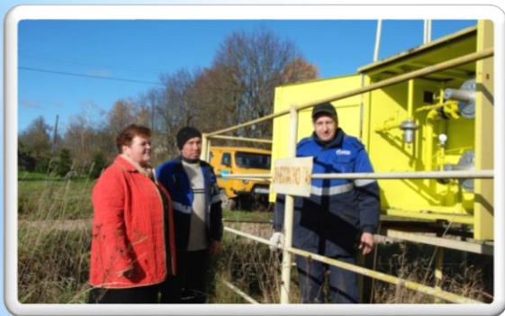
Построен газопровод низкого давления, 6,6 км (4,5 млн.руб.)
